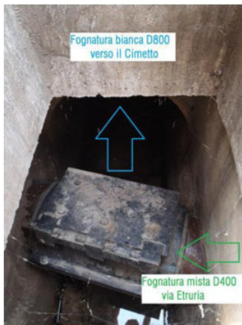
Foto 1: Interferenza reti mista e bianca in via Etruria
